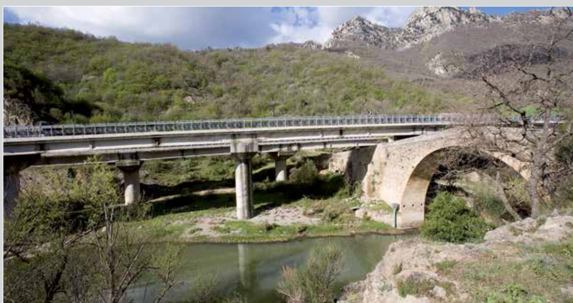
■ S.S. 407 "Basentana" - Ponte della Vecchia
