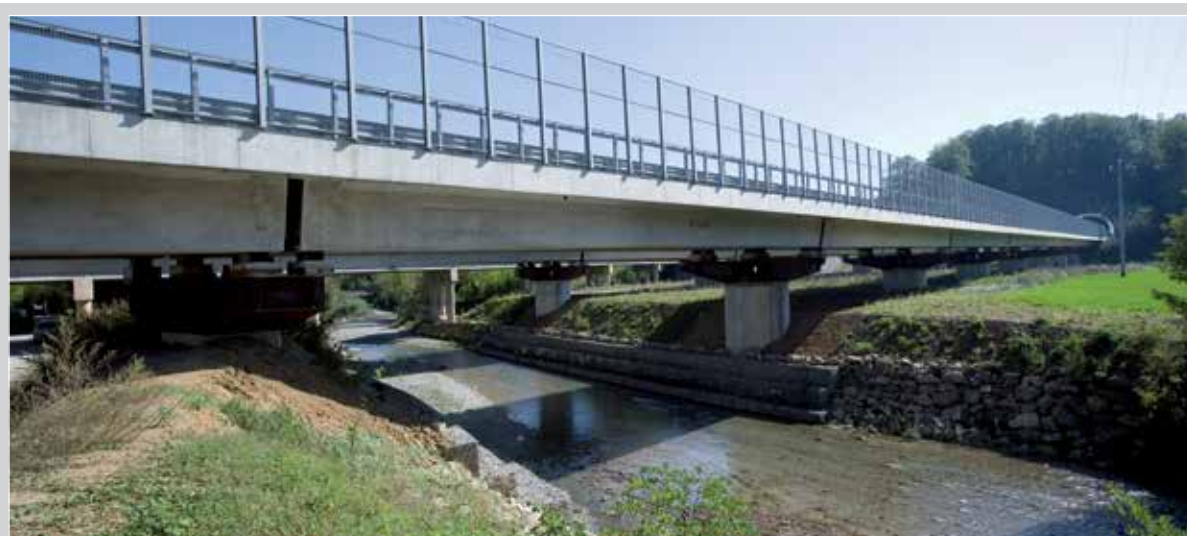
■ Autostrada A3 Salerno-Reggio Calabria - Viadotto Calore
