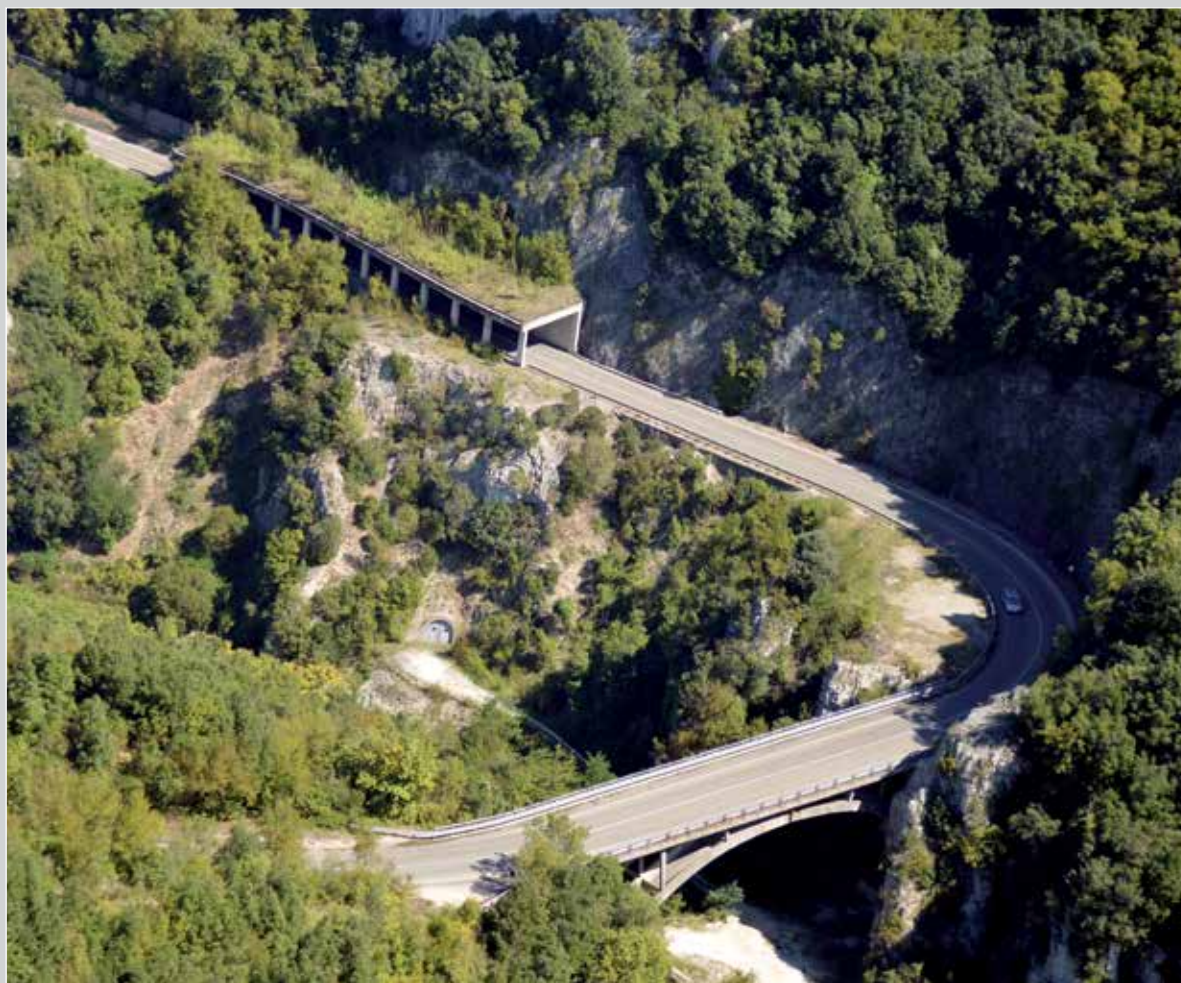
■ S.S. 448 "di Baschi" - Ponte della Pasquarella
