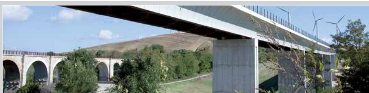
■ S.S. 87 "Sannitica" - Viadotto Macchia della Selva
