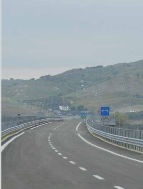
■ S.S. 106 "Jonica" - Viadotto Corace
