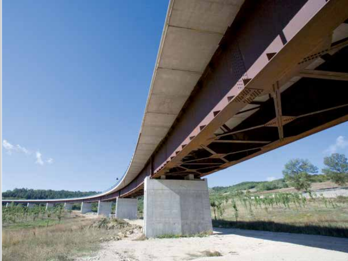
■ S.S. 87 Sannitica - Viadotto Fonte Lana
