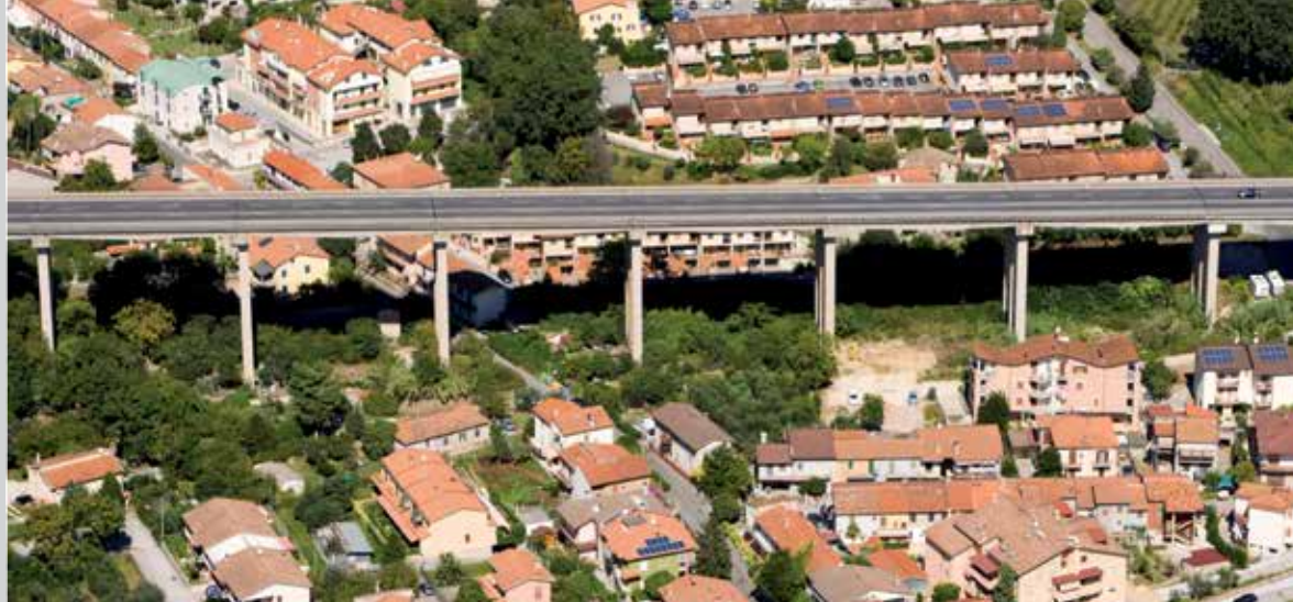
■ S.S. 675 "Orte-Terzi" - Viadotto Toano
