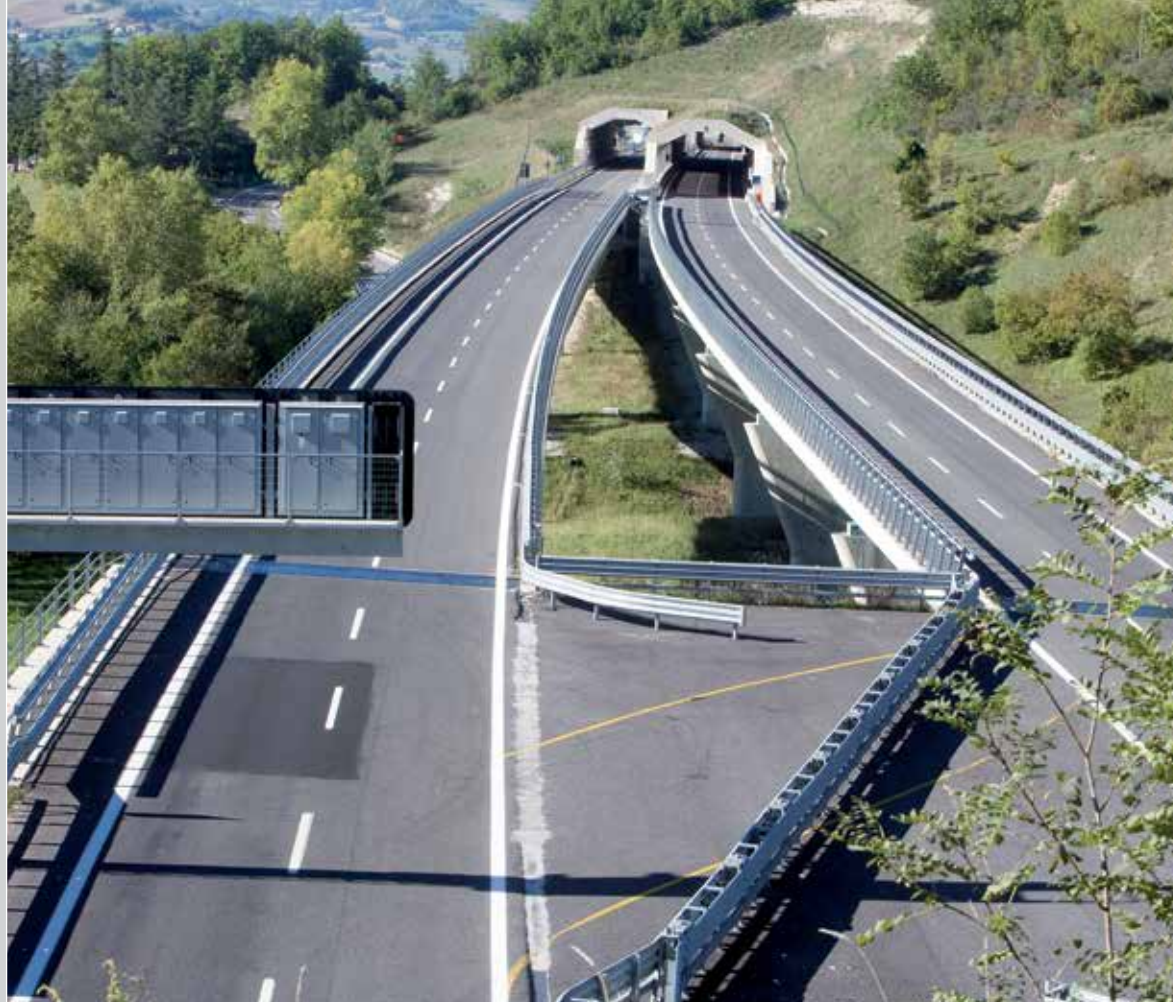
■ S.S. 77 "della Val di Chienti"- Viadotto Polverina
