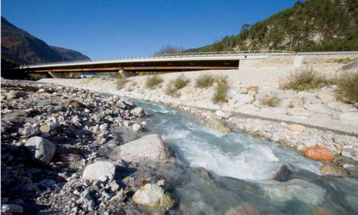
■ S.S. 13 "Pontebbana" - Viadotto S. Caterina
