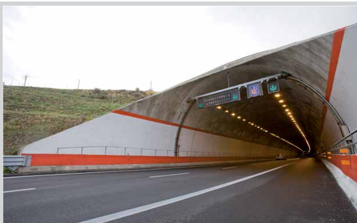
■ Autostrada Catania-Siracusa - Galleria S. Demetrio
