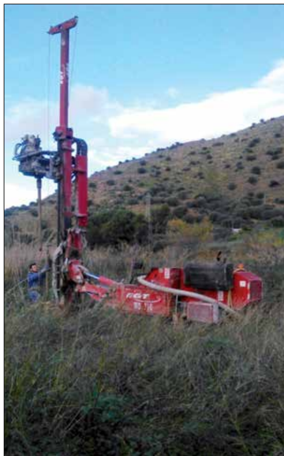
Figura 3 - Realizzazione di sondaggi per prelievo di campioni in profondità
