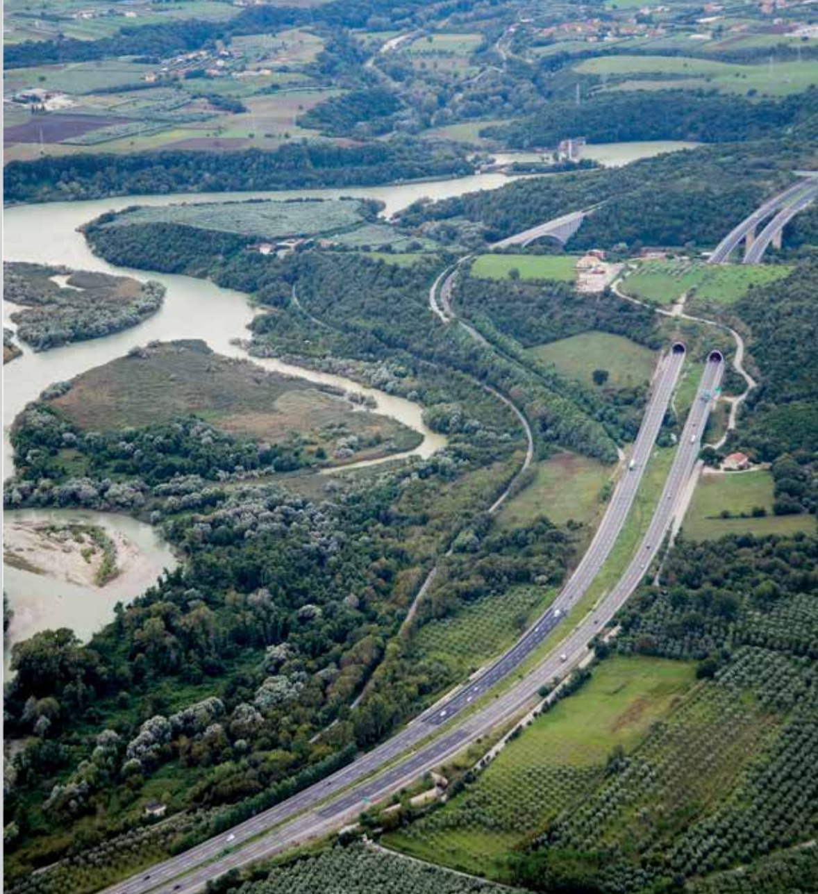
■ Autostrada A3 Salerno-Reggio Calabria - Galleria Persano
