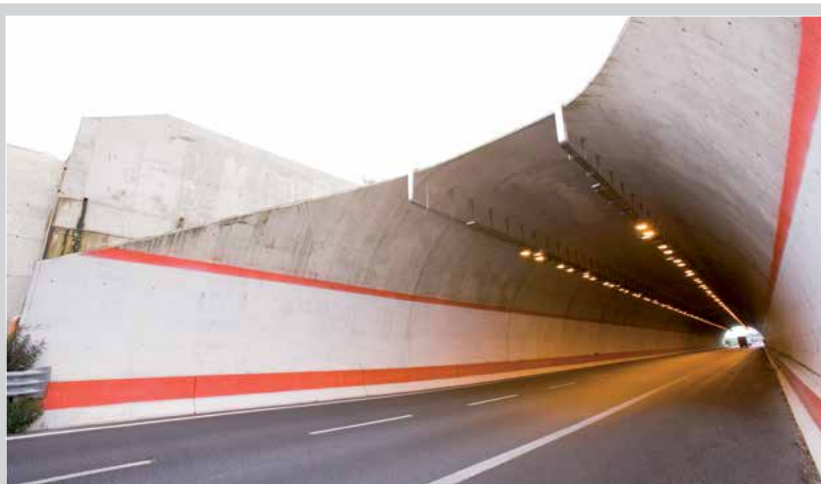
■ Autostrada A3 Salerno-Reggio Calabria - Galleria Seppia
