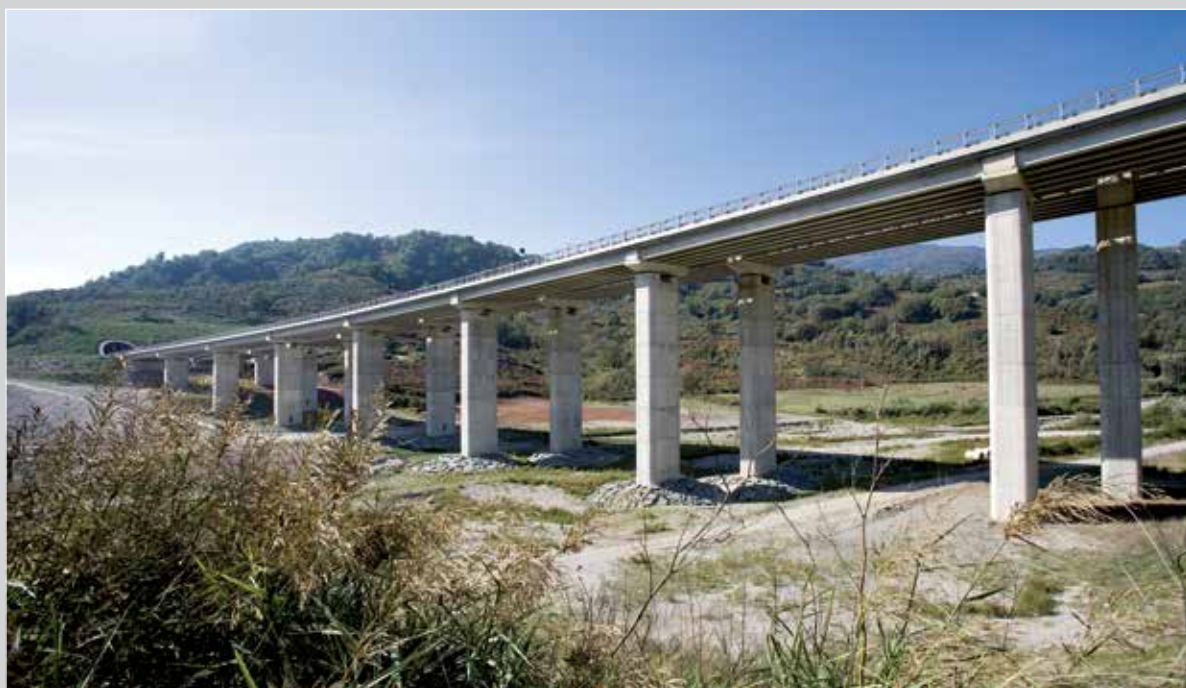
■ Autostrada A3 Salerno-Reggio Calabria - Viadotto sul Torrente Carito
