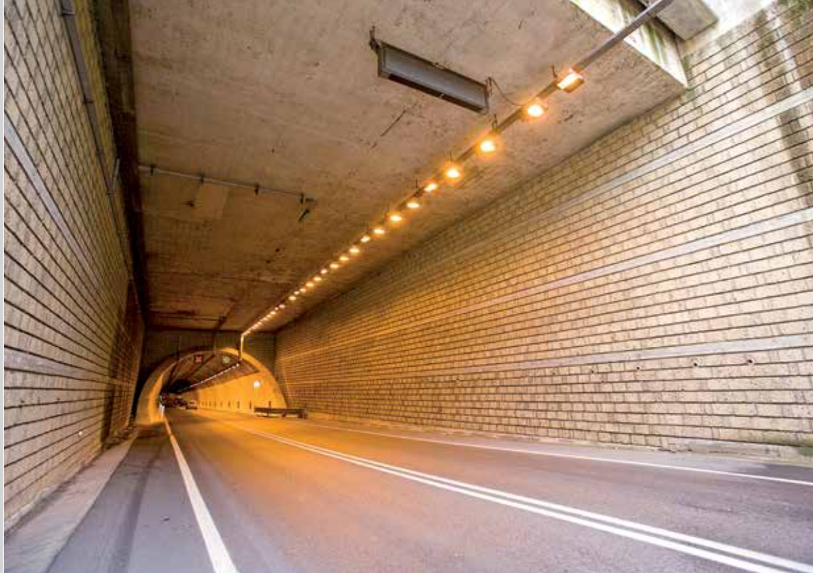
■ S.S. 700 "della Reggia di Caserta" - Galleria Parco della Reggia
