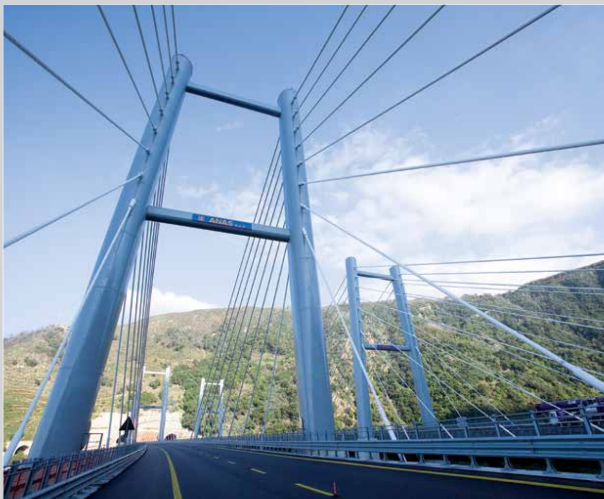
■ Autostrada A3 Salerno-Reggio Calabria - Viadotto Favazzina
