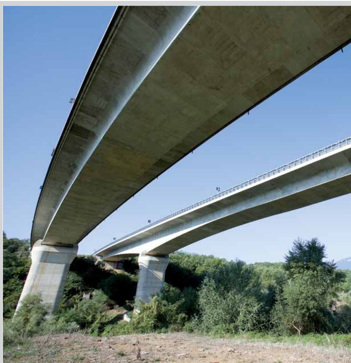
■ Autostrada A3 Salerno-Reggio Calabria - Ponte Tensa
