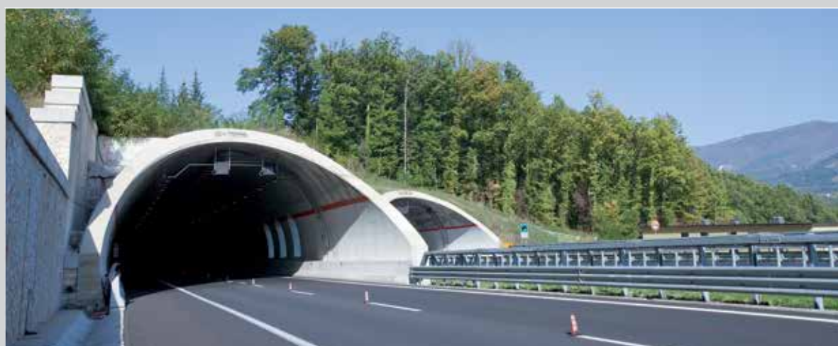
■ Autostrada A3 Salerno-Reggio Calabria - Galleria Cerreta Nord
