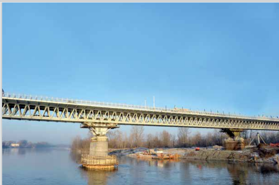
■ S.S. 9 "Emilia" - Ponte sul Po tra Piacenza e S. Rocco al Porto
