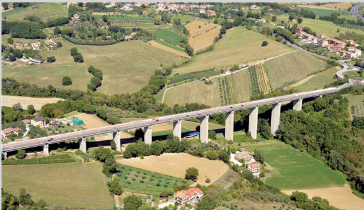
■ S.S. 675 "Umbro-Laziale" - Viadotto Fiacchignano
