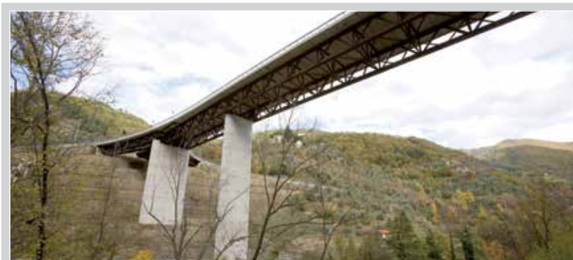
■ S.S. 28 "del Colle di Nava" - Viadotto Arroscia
