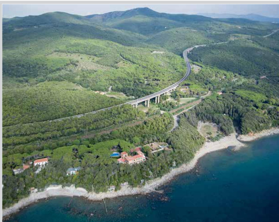
■ S.S. 1 "Aurelia" - Viadotto Fortulla
