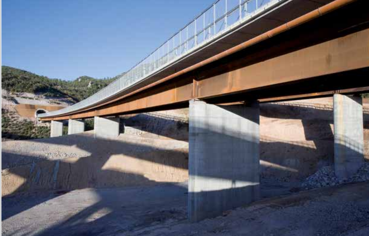
■ Autostrada A3 Salerno-Reggio Calabria - Viadotto Caballa
