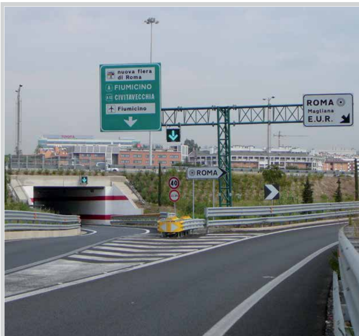
■ Nuova rampa di collegamento tra il GRA Roma e l'Autostrada A91 Roma-Fiumicino
