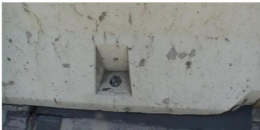
**Figura 3 – Tirafondo di fissaggio assente.**
