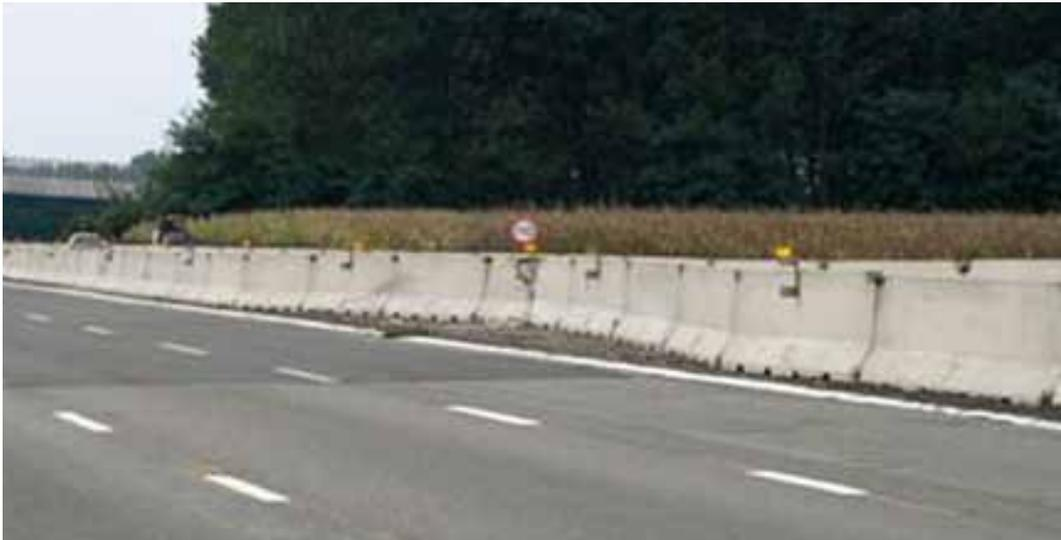
**Figura 6 – Deformazione della barriera in New Jersey a seguito di impatto medio/leggero.**
