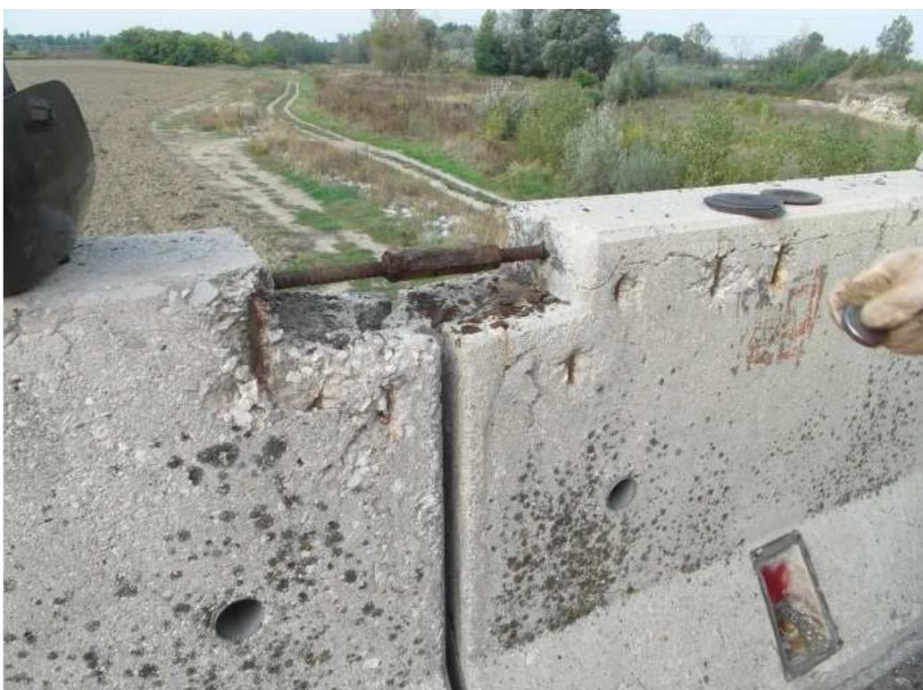
**Figura 1 – Manicotti di collegamento deteriorato.**
