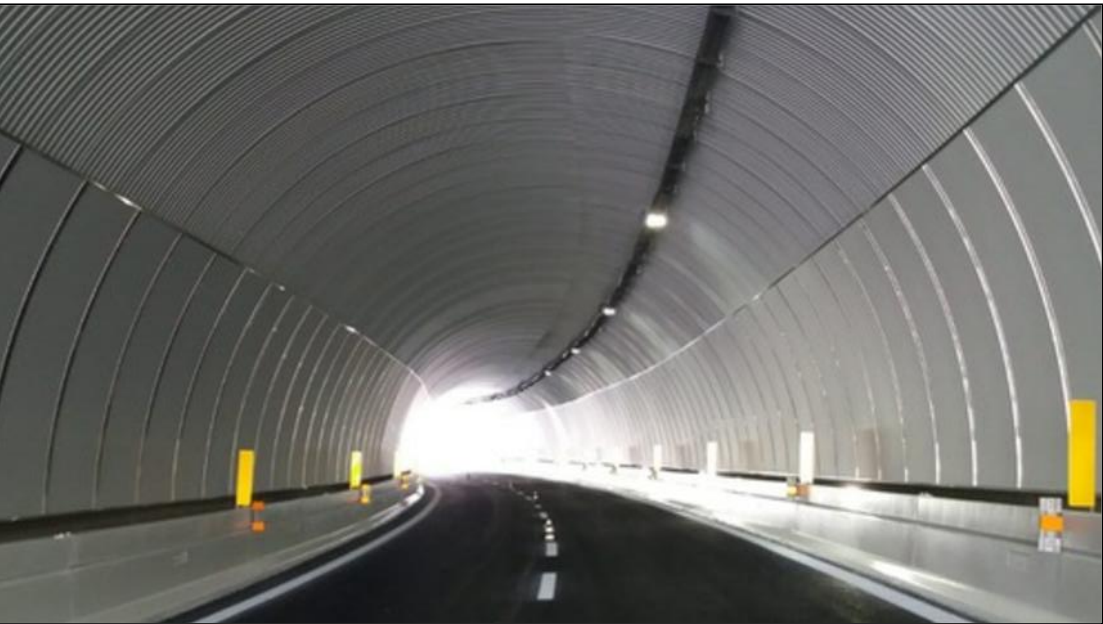
Figura 1. Rivestimento concluse le lavorazioni
