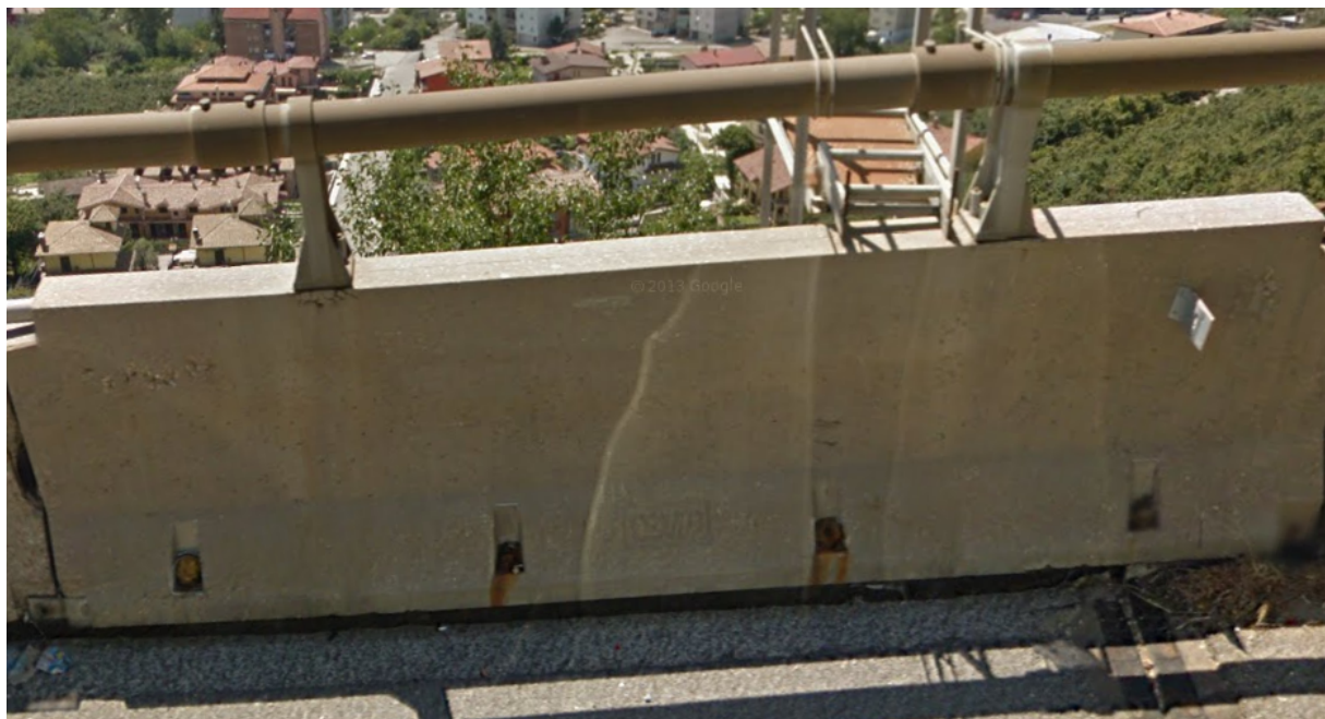
Figura 2 – Tirafondi di fissaggio sul cordolo soggetti a corrosione.
