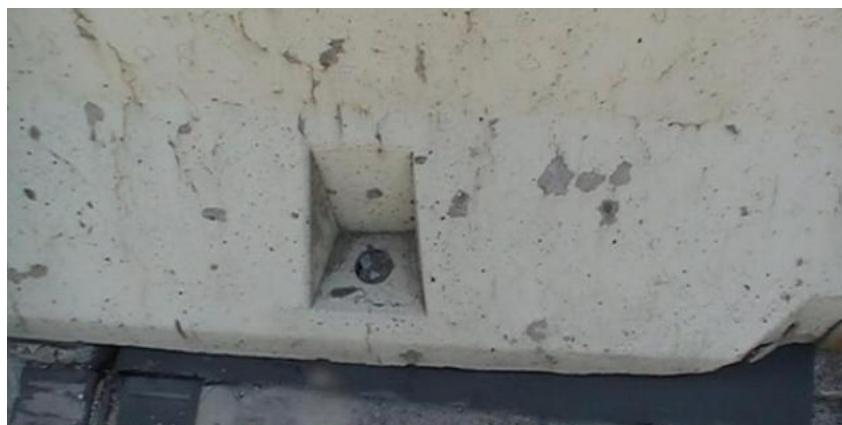
Figura 3 – Tirafondo di fissaggio assente.
