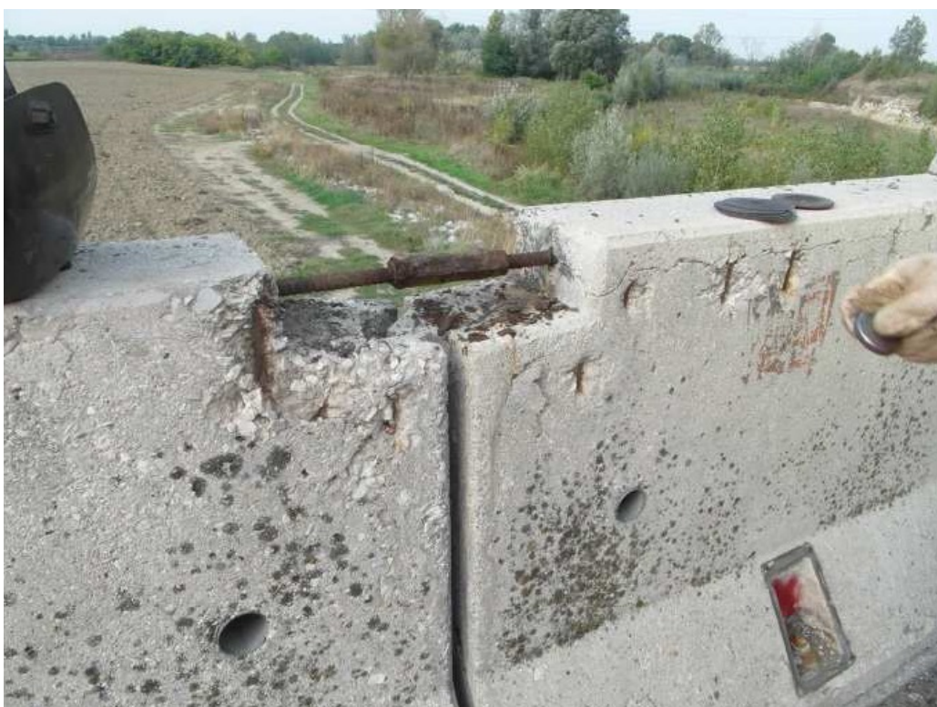
Figura 1 – Manicotti di collegamento deteriorato.
