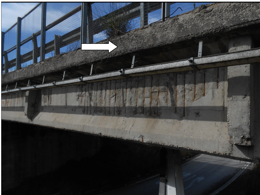
Figura 1 – Individuazione del cordolo bordo-ponte.
