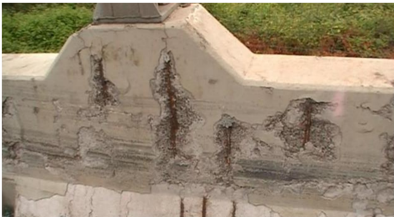
Figura 5 – Espulsione del copriferro e corrosione dei ferri di armatura.
