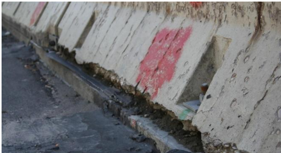
Figura 4 – Deterioramento del calcestruzzo con esposizione dei ferri di armatura.
