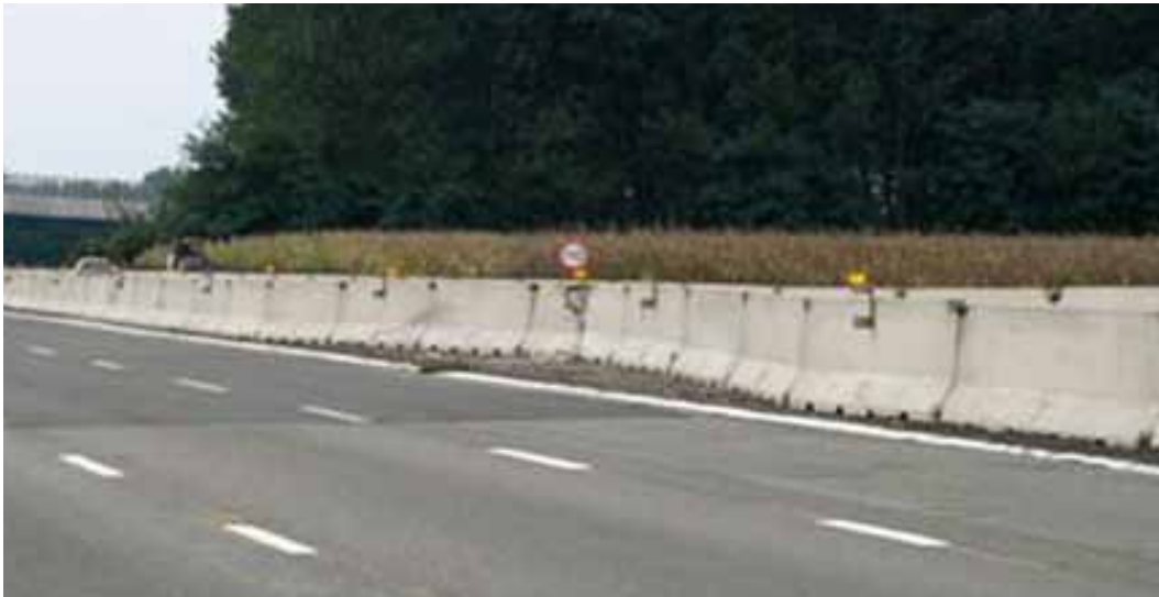
Figura 6 – Deformazione della barriera in New Jersey a seguito di impatto medio/leggero.
