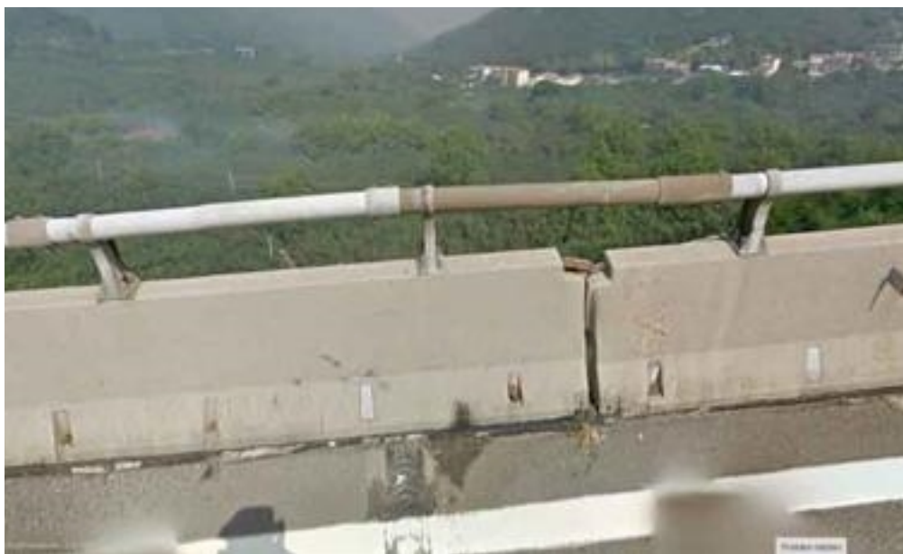
Figura 8 – Deformazione del collegamento longitudinale di una barriera in New Jersey a seguito di impatto pesante.
