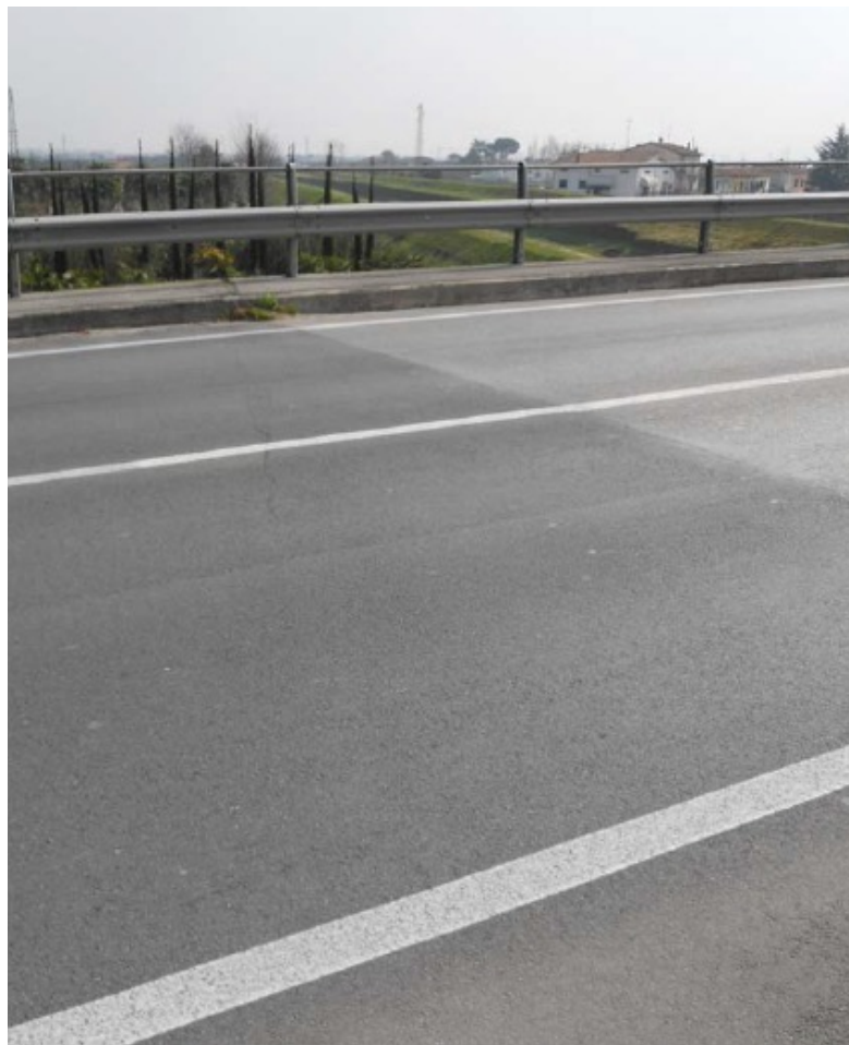
Figura 93 - Giunto di sottopavimentazione
