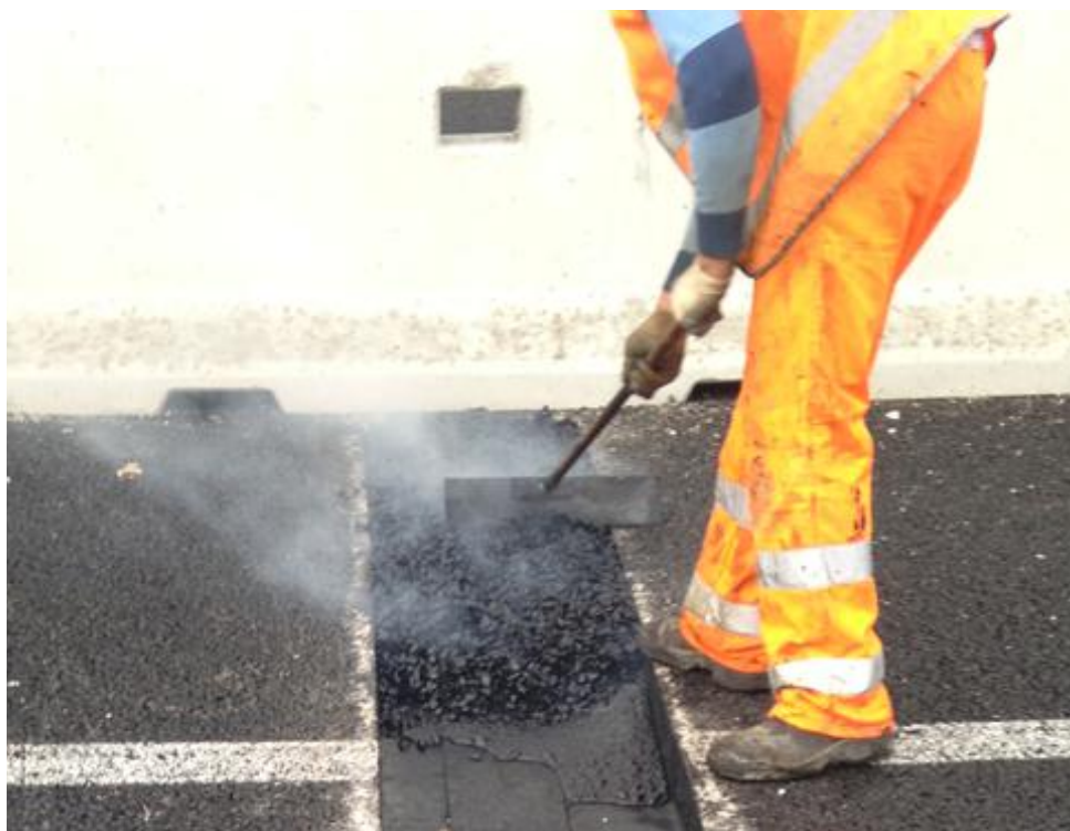
Figura 108 - Posizionamento dell'aggregato scaldato
