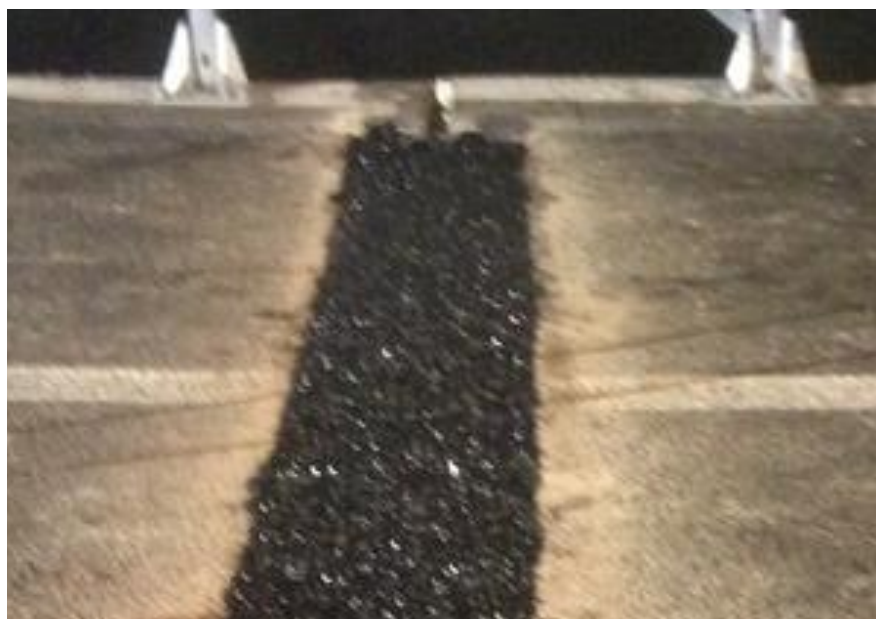
Figura 95 - Giunto a tampone viscoelastico
