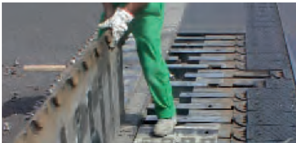
Figura 110 - Sostituzione di un modulo
