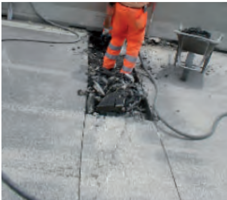
Figura 107 - Taglio preliminare della pavimentazione stradale
