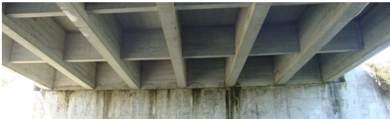
Figura 83 – Vista intradosso impalcato
