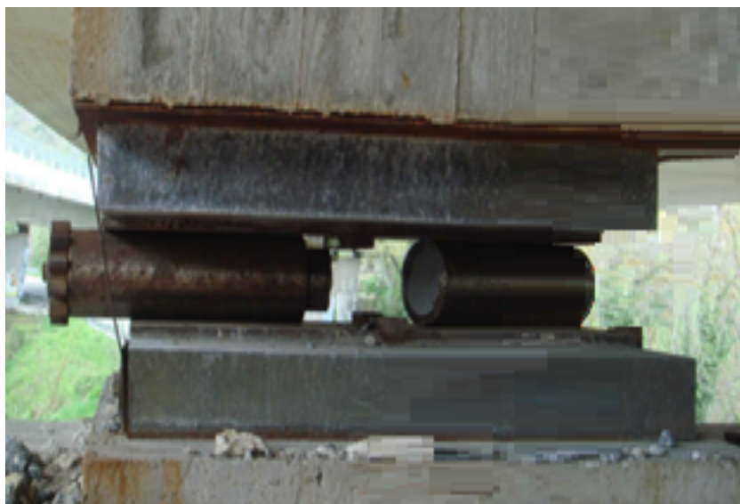
Figura 70 – Scivolamento del vincolo a cerniera in acciaio.
