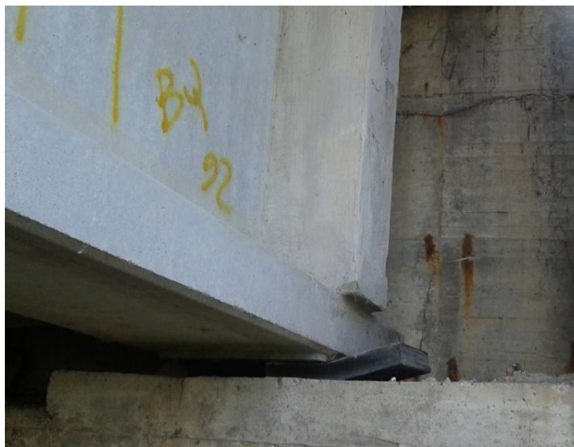
Figura 75 – Scivolamento dell'appoggio elastomerico
