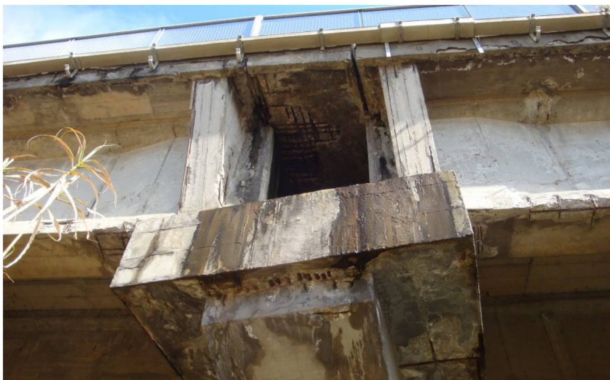
Figura 85 – Ammaloramento del pulvino
