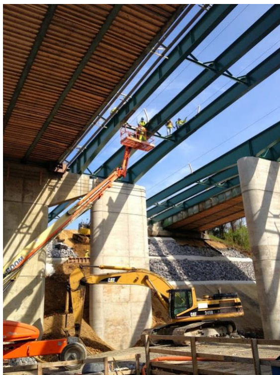
Figura 4.105 - Esempio di allargamento di ponte esistente con travi metalliche poggiate su nuovi appoggi
