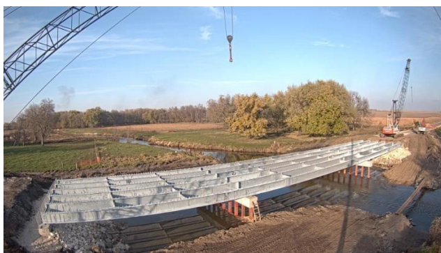
Figura 6.13 - USA - Buffalo Creek Bridge: ponte di 60 m circa con strutture di acciaio di implacato zincato a caldo e uso del tondino zincato nei componenti di cemento armato
