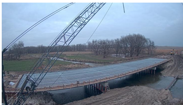
Figura 6.13 - USA - Buffalo Creek Bridge: ponte di 60 m circa con strutture di acciaio di implacato zincato a caldo e uso del tondino zincato nei componenti di cemento armato
