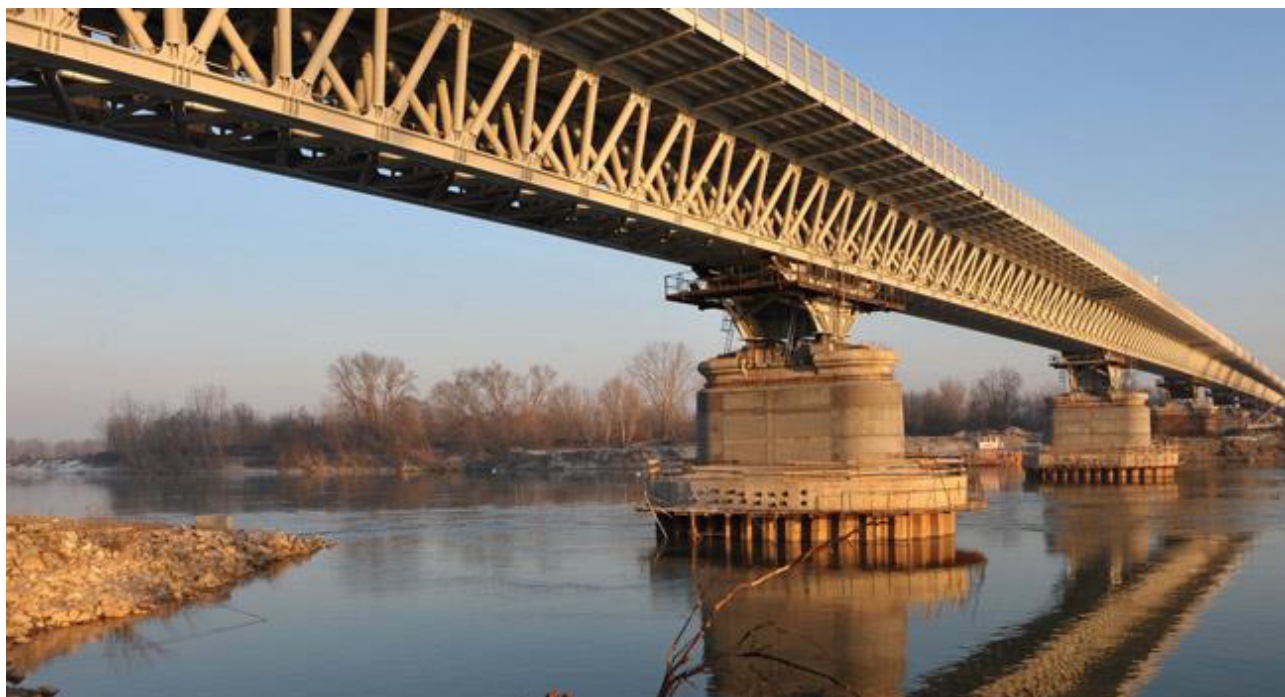
Figura 6.12 - Nuovo ponte sul fiume Po SS9 "Emilia" (Piacenza) di committenza ANAS, zincato a caldo e verniciato
