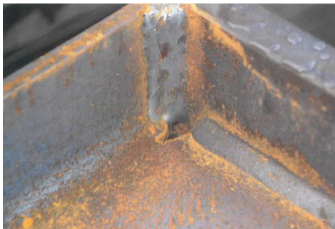
Figura 6.18 - La presenza del cordone di saldatura rende insufficiente la sezione del foro di drenaggio [35]
