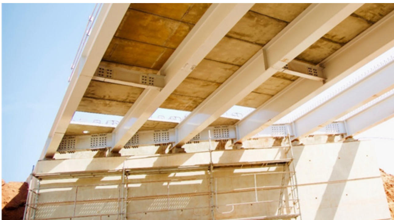
Figura 4.21 – Esempio di appoggio in carpenteria metallica e traversi in appoggio e in campata
