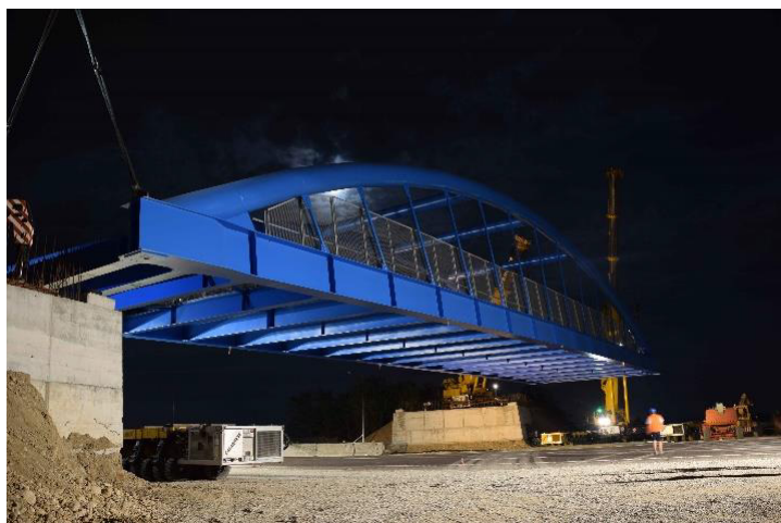
Figura 7.1 - Varo Cavalcavia via Cavallera, Castegnato (BS) e Ponte sul Piave S.P. 92 “delle Grave”
