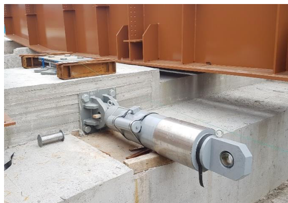
Figura 5.8 - Dissipatore sismico fluidodinamico
