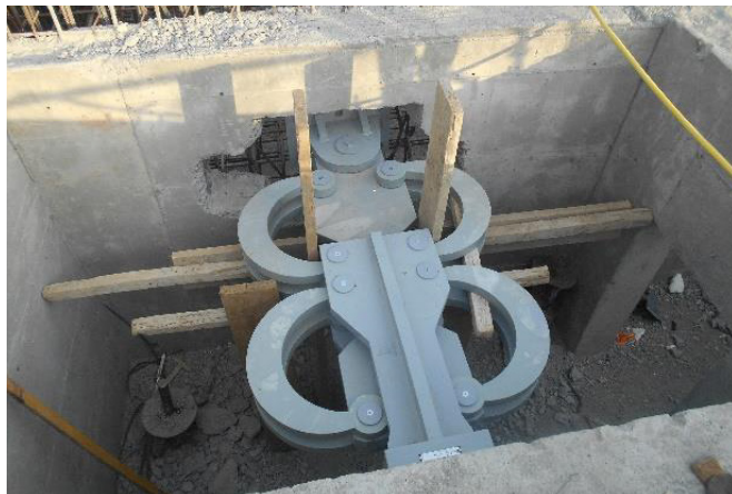
Figura 5.7 – Dissipatore sismico isteretico
