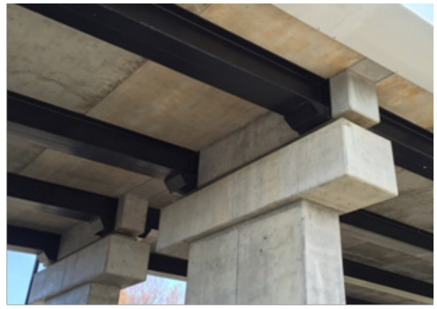
Figura 4.18 - Immagini di cantiere per il sistema di travi accoppiate
