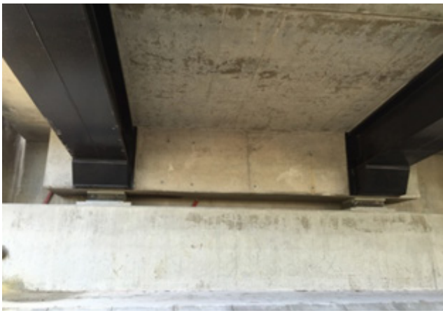
Figura 4.18 - Immagini di cantiere per il sistema di travi accoppiate
